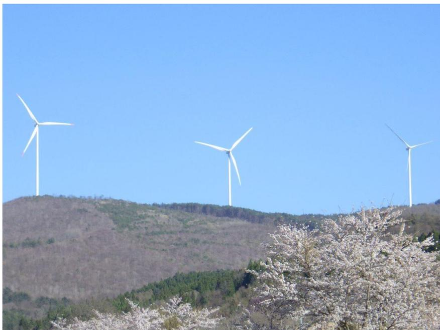
本発電所は、岩手県遠野市および住田町の両自治体に位置し、単機出力4,200kWのベスタス社製風力発電機を27基設置、総出力は113,400kWとなります。発電機は大船渡市の大船渡港から陸揚げされ、現場への輸送、据付、建設等の工事請負は清水建設株式会社が行いました。これは一般家庭の約84,000世帯相当分（参考：遠野市と住田町の総世帯数は約12,000世帯）の電力供給に相当し、年間約10万トンの二酸化炭素削減効果（参考：遠野市と住田町の家部門の令和2年度CO<sub>2</sub>排出量は約50,000トン
