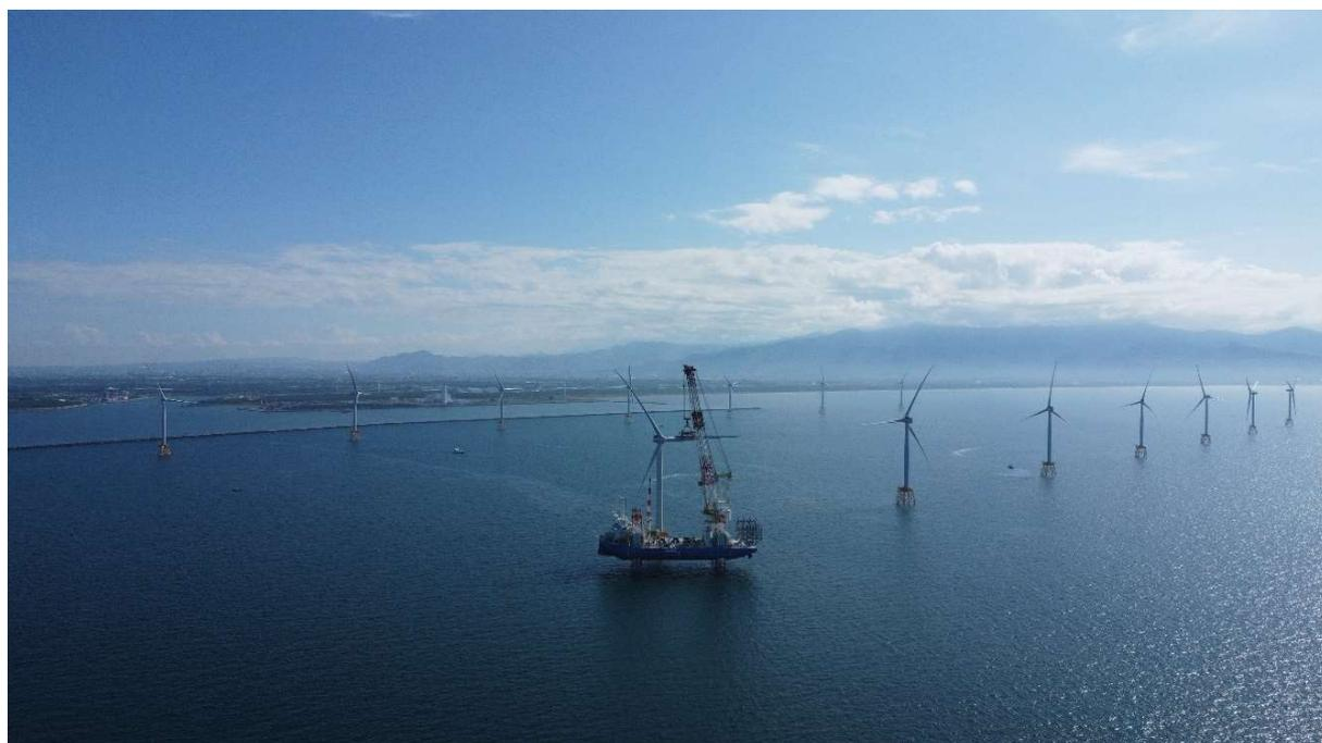
本発電所は、北海道の石狩湾新港に位置し、単機出力 8,000kW の Siemens Gamesa Renewable Energy 製風力発電機を 14 基設置、総出力は 112,000kW となります。陸上工事は鹿島建設株式会社、洋上工事は清水建設株式会社と日鉄エンジニアリング株式会社による共同事業体が行いました。
